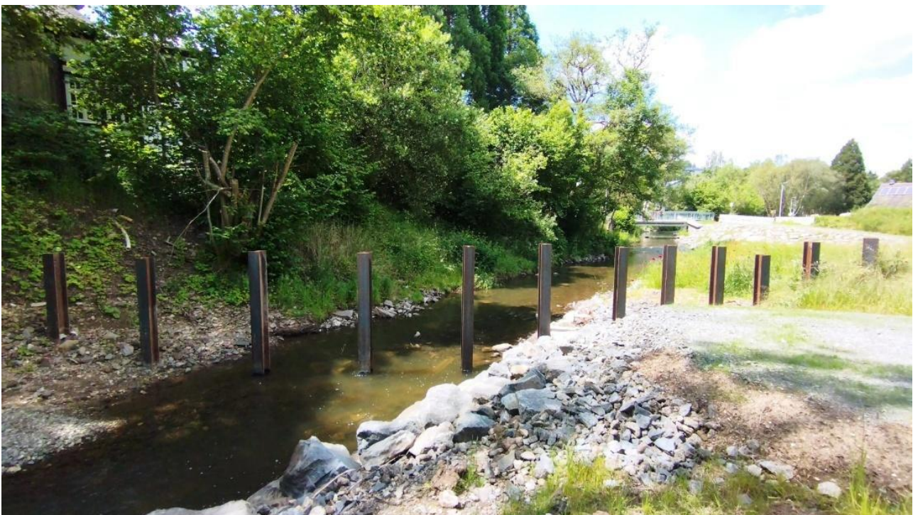
Abb. 4: Beispiel einer Treibgutfalle bei Nettersheim. [Foto WVER]
